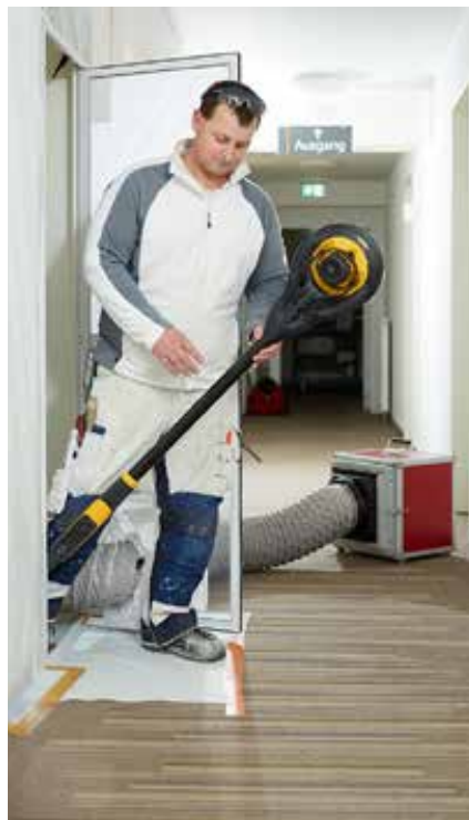
Mit modernen technischen Geräten lassen sich Stäube bereits beim Arbeiten deutlich mindern.
