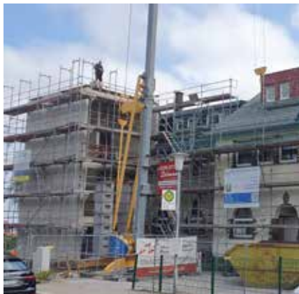
Rund 50 Baumaßnahmen koordiniert die WSGH im Jahr für Privatkunden, Gewerbe, Hausverwaltungen und Kommunen.
